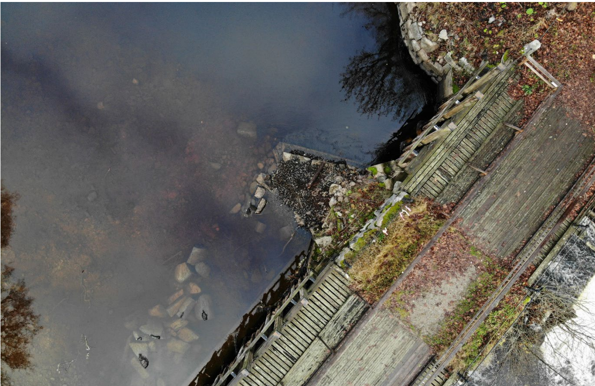
Figur 4. Foto från arbetet med att åtgärda dammläckaget 2021. På fotot delar av botten uppströms dammen då den var delvis avsänkt. (Norconsult).
