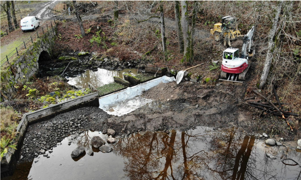
Figur 3. Foto från arbetet med att åtgärda läckaget vid dammen 2021. På fotot syns den tillfartsväg som anlades vid det tillfället och som kan nyttjas som tillfart till ån även vid utrivning av dammen. (Norconsult).
