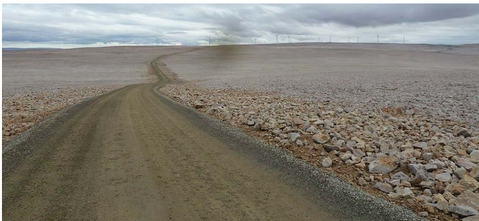
Bild 2. Bild tagen söderut längs tillfartsvägen på Ráikkočearru-platån. Vindturbinerna ses i bakgrunden. På platån finns det praktiskt taget ingen vegetation. Bilden är tagen i södergående riktning.
