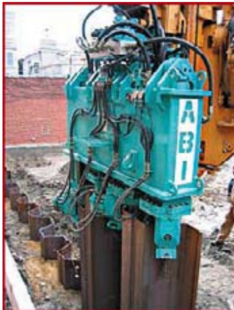
Figur A1.2. Installation av tätspont av stål.
