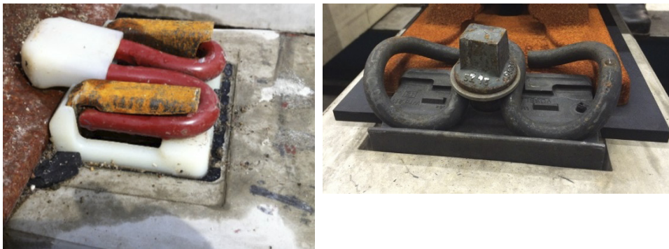
Figur 3. Isolator av PA66 (vit) vid befästningen av en betongsliper (vänster). Isolator (svart under metall) till en spårväxel (höger). 45
