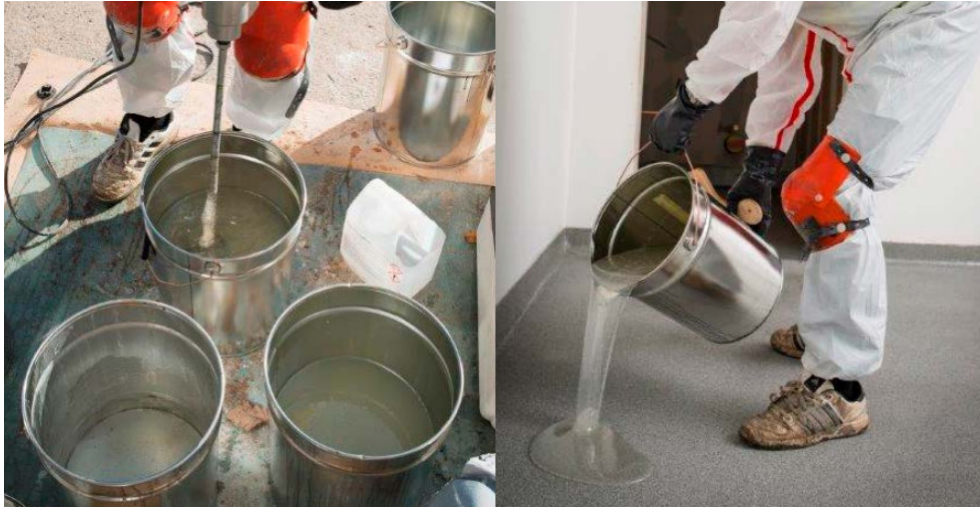
Figur 2. Förberedelser och applicering av Epoxi 37
