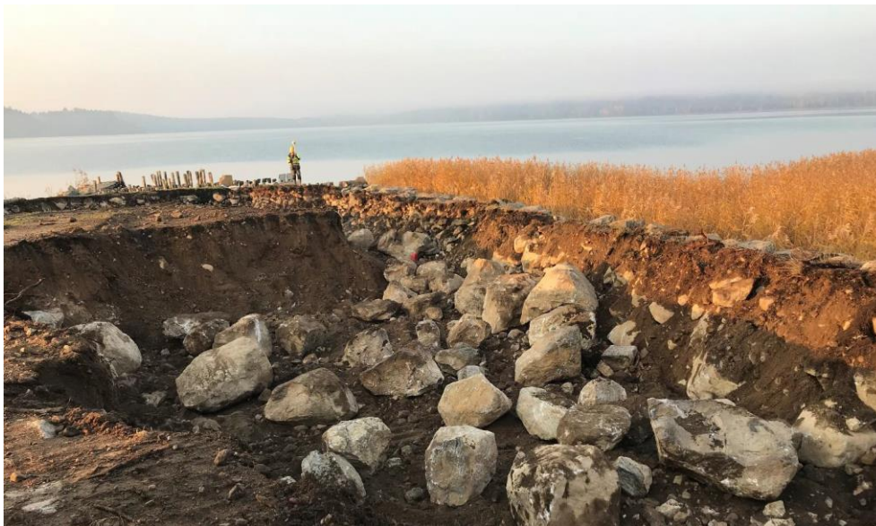
Figur 9. Inmätning av schakt på piren (Projekt- och erfarenhetsrapport över saneringen av f.d. impregneringsområdet i Kagghamra, Botkyrka kommun, Golder Associates AB i samarbete med Botkyrka kommun, 2020-04-24)
